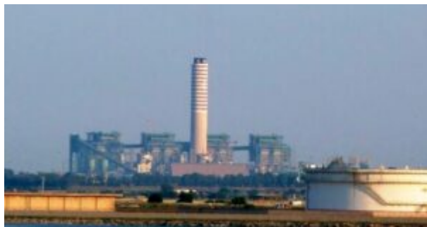
Centrale Enel Brindisi
