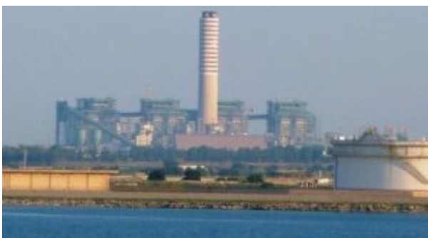
Brindisi – Centrale di Cerano
