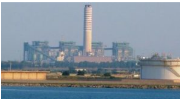
Brindisi – Centrale di Cerano
