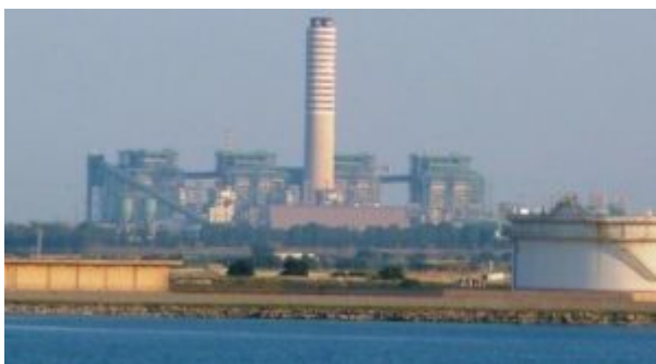
Brindisi – Centrale di Cerano
