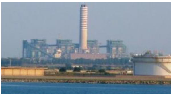
Brindisi – Centrale di Cerano
