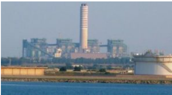
Brindisi – Centrale di Cerano
